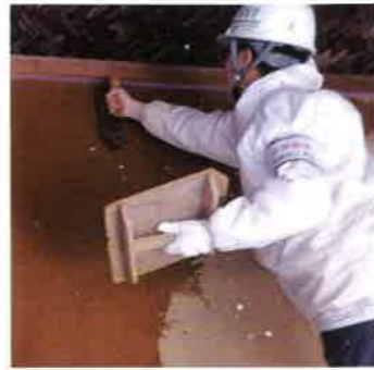
黄土の上塗り
