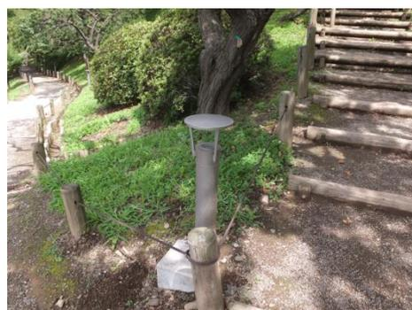
種類の異なる灯・基礎が見える整備、雨ざらしの汚れ・基礎の見えない処では、跳ね返りの汚れが放置されている。(照明の清掃管理が必要)
