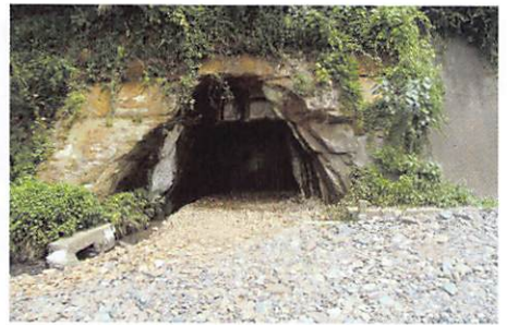
岩樋採掘洞窟跡(民地内)入り口はコンクリートで閉塞されています
